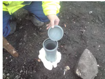
Підготовлена для закачування ОКСИЗИНУ свердловина з перфорованою трубою
