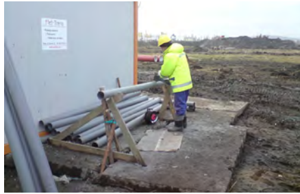
Виготовлення перфорованих труб d = 108 мм на полігоні
