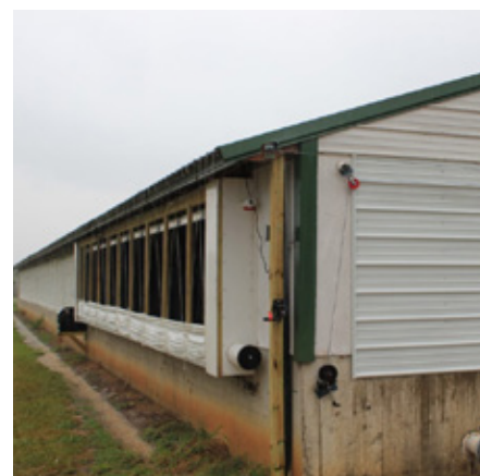
Фото 1. Охолодження повітря за рахунок ефекту випаровування і тунельної вентиляції
