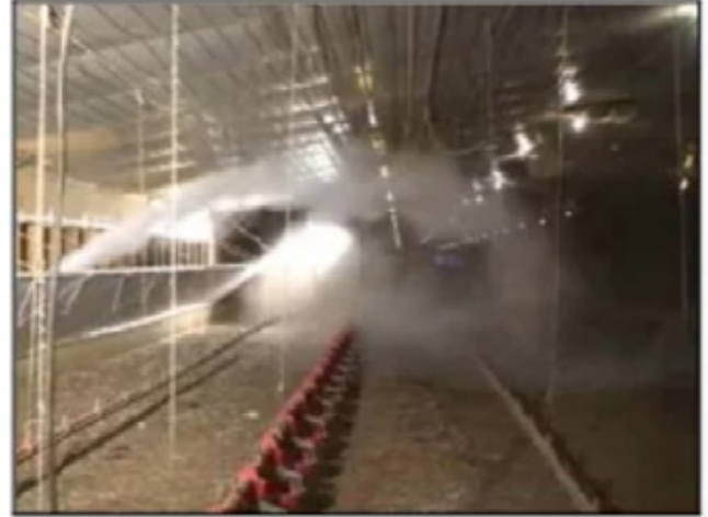
Фото 7, 8. Повітря, що надходить через тунельні стулки, рухається уздовж стелі, а потім по колу назад, до бічної стіни, вже на рівні підлоги
