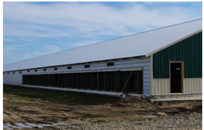
Фото 2. Випарні касети висотою 1,52 м
