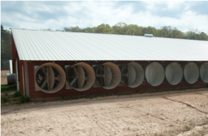
Фото 3. Тунельні вентилятори, розміщені на бічній стіні, починаючи з торцевої стіни
