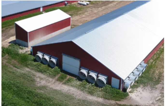
Фото 4. Тунельні вентилятори, розміщені на бічній та торцевій стіні будинку, шириною 18 м
