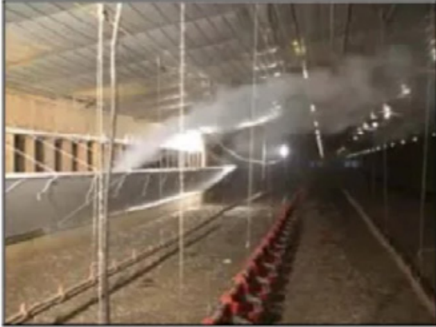
Фото 7, 8. Повітря, що надходить через тунельні стулки, рухається уздовж стелі, а потім по колу назад, до бічної стіни, вже на рівні підлоги
