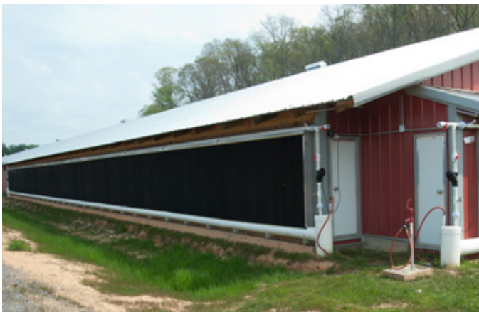
Фото 1. Випарні касети висотою 1,83 м
