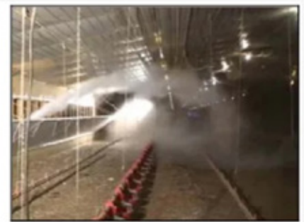
Фото 4 та 5. Повітря, що надходить через тунельні стулки, рухається вздовж стелі, а потім по колу назад, до бічної стіни, вже на рівні підлоги
