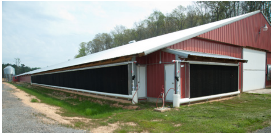
Фото 3. Касети системи випарного охолодження
