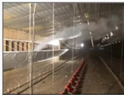
Фото 4 та 5. Повітря, що надходить через тунельні стулки, рухається вздовж стелі, а потім по колу назад, до бічної стіни, вже на рівні підлоги
