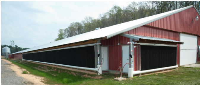
Фото 3. Система випарного охолодження в пташнику
